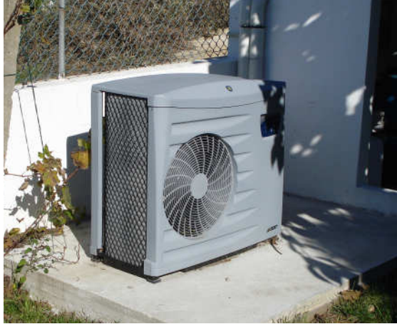
Instalação de Bomba de Calor para piscina
