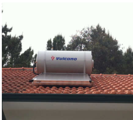
Instalação de Termossifão
