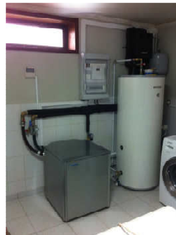
Instalação de Bomba de Calor de Alta Temperatura e Sistema Solar Térmico
