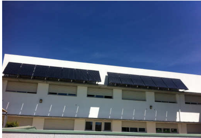
Instalação de 14 Colectores Solares Térmicos
