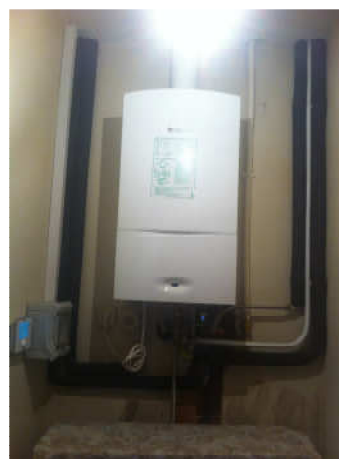
Instalação de Caldeira de condensação e radiadores + Solar Térmico
