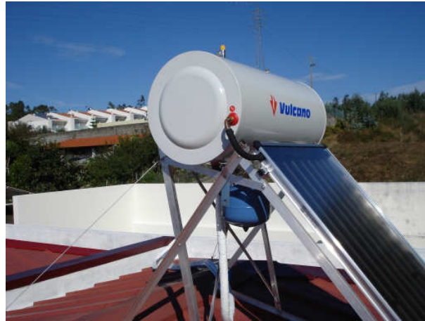
Instalação de Termossifão
