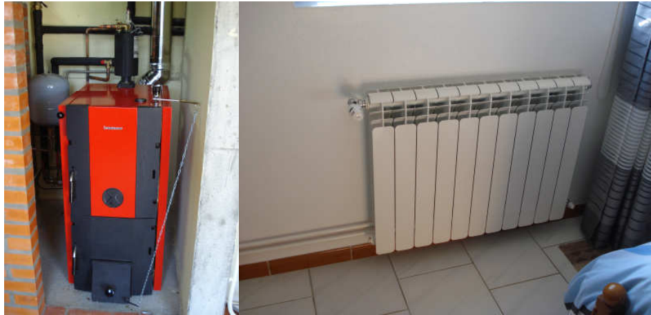
Instalação de Caldeira a Lenha e Radiadores
