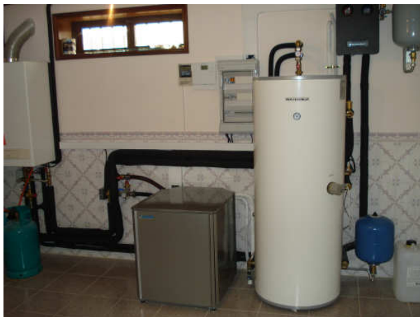
Instalação de Bomba de Calor de Alta Temperatura, Radiadores e Sistema Solar Térmico
