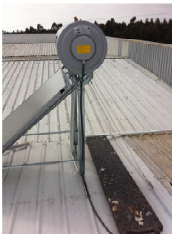
Instalação de Termossifão
