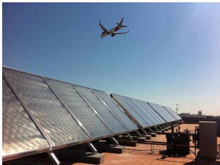
Instalação de 20 Colectores Solares Térmicos
