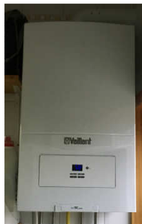
Instalação de Caldeira de Condensação
