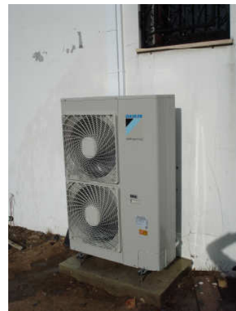
Instalação de Bomba de Calor de Alta Temperatura, Radiadores e Sistema Solar Térmico
